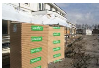
Diffutherm-platen droog en vlak opslaan op de bouwplaats.
