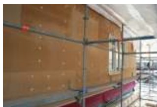
Bevestiging van Diffutherm-platen.
