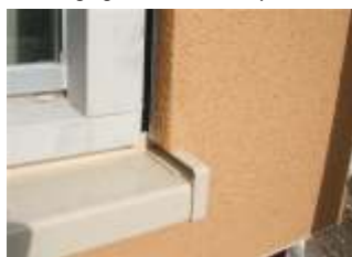
Waterslagen uit één stuk voorzien van stucwerk-kopschotten, ingewerkt in het systeem.
