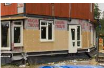
DIFFUTHERM tijdens de bouwphase
