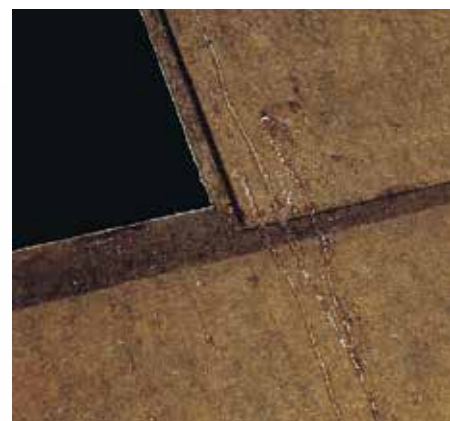
Foto boven: waterdichte tand- en groefverbinding van de Celit 4D onderdakplaat.
